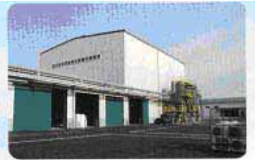
施設全景 TV棟と手分解/破碎棟、貯留ヤードです。
