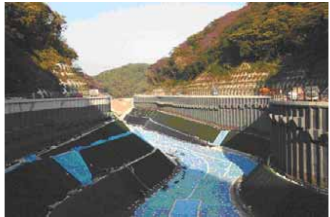
(横須賀市芦名 産業廃棄物最終処分場建設風景 平成17年11月25日撮影)
