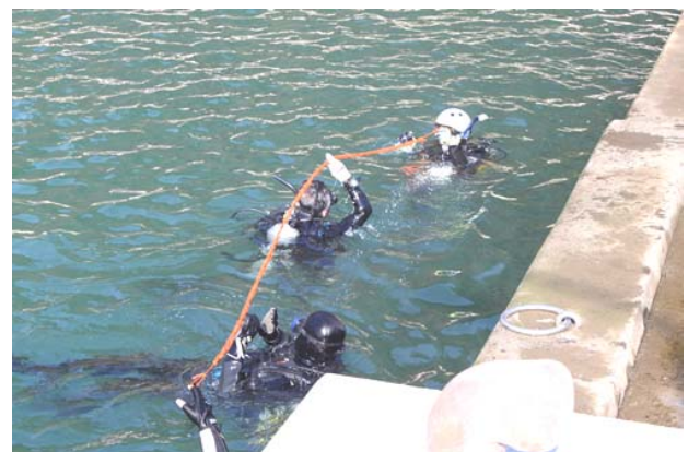
活動報告会:透明度が悪い時にはダイバー同士がロープを持って潜水し、連携してまず状況調査を行なった
